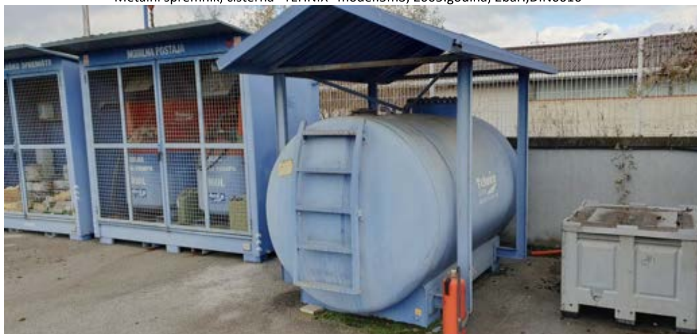
Metalni spremnik, cisterna "TEHNIX" model:5m3, 2005.godina, 2bar.,DIN6616
