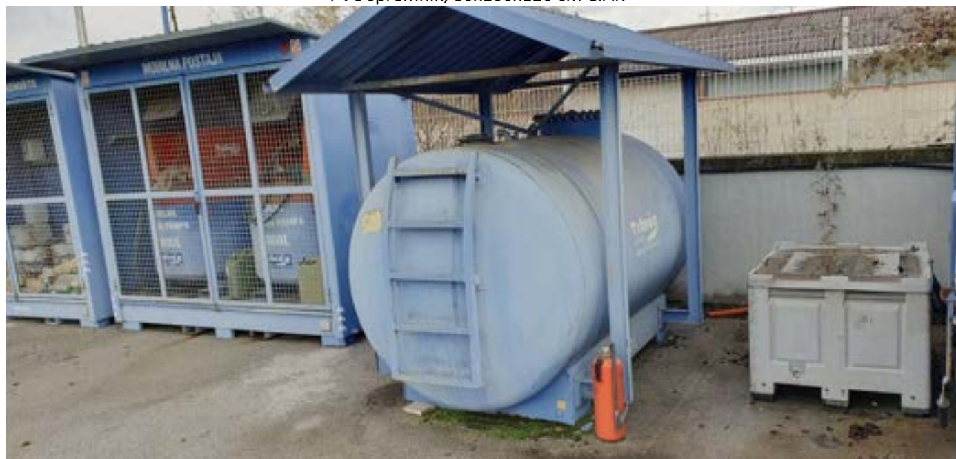
Metalni spremnik, cisterna "TEHNIX" model:5m3, 2005.godina, 2bar.,DIN6616
